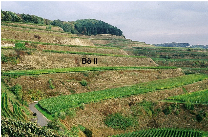
Abbildung 1: Blick auf das neustrukturierte Reb Gelände. Die untersuchte Böschung ist die zweite Böschung oberhalb des Teersträßchens. Gut zu sehen ist eine Zweiteilung der Böschung in einen unteren Bereich mit anstehendem hellem Löss (Abtragsfläche) und einem oberen Bereich mit aufgetragenem Löss (Auftragsfläche), der sich durch einen stärkeren Bewuchs auszeichnet. Ganz unten links oberhalb der Straße kann man das alte kleinterrassierte Reb Gelände (R) erkennen.
