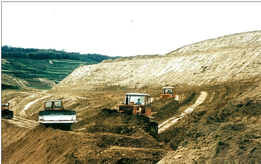
Abbildung 2: Maschineneinsatz bei der Gestaltung des Gewanns Baßgeige während der Flurbereinigung 1978. Gesamtgröße des Umlegungsgebietes Baßgeige rund 2,5 km 2 . Links unterhalb des Waldes ist das kleinterrassierte alte Rebgelände (R) zu erkennen, welches als Impfzelle für das Neuland erhalten blieb.
